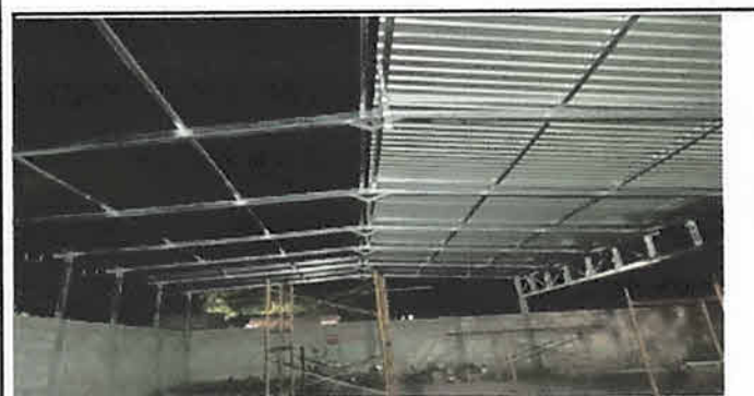
Foto 5: Módulo 1 iniciación de colocación de la lámina aluzink en la galera.
