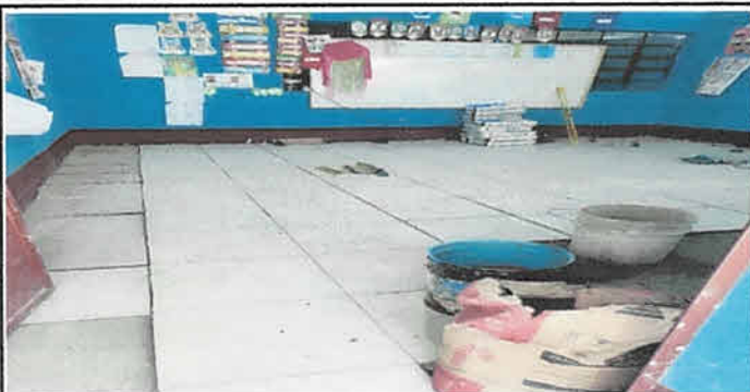
Foto 3: Módulo 2: colocación del piso cerámico en el salón de clases.
