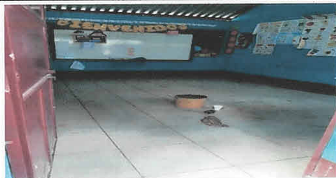
Foto 5: Módulo 2: colocación de sisa en el piso del aula.
