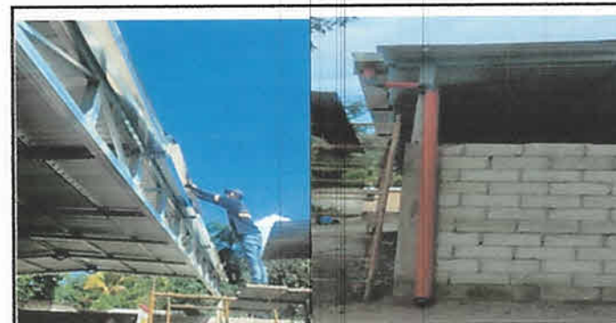
Foto 6: Módulo 1 Colocación de canales e instalación de tubería para caída de agua.
