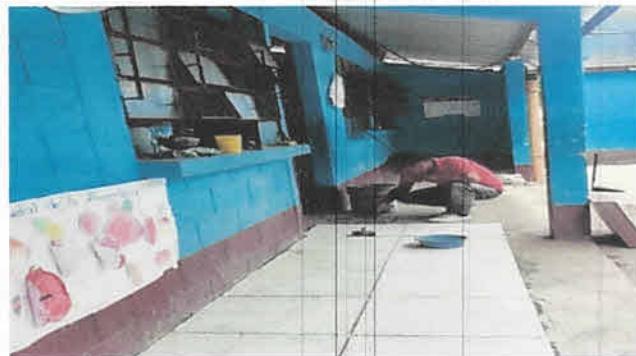
Foto 2: Módulo 2: colocación de piso cerámico en corredor.
