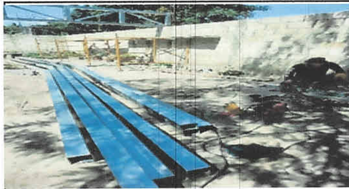
Foto 2: Módulo 1 se inicia con la fabricación y colocación de la estructura metálica para la colocación del techo en la galera.
