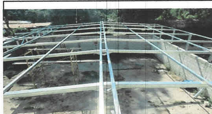
Foto 4: Módulo 1 suministro e instalación de cargalaminas en la estructura metálica de la calera.
