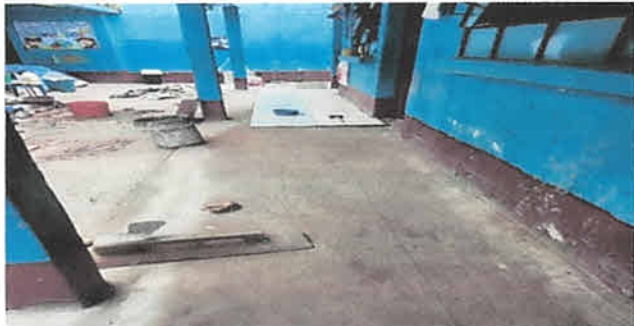
Foto 1: Módulo 2: Iniciación de colocación de piso cerámico en el corredor de aulas.
