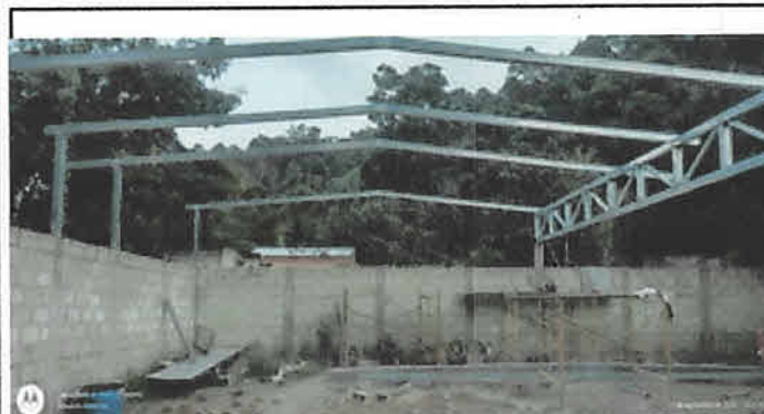
Foto 3: Módulo 1 colocación de tijeras para la galera.
